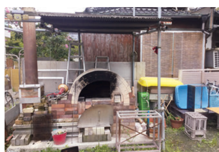
改装前の窯焼き周辺
