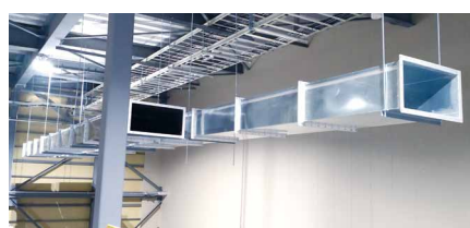
空調換気ダクトの施工
