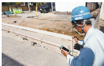
「測量の効率化」で1人作業化した測定現場
